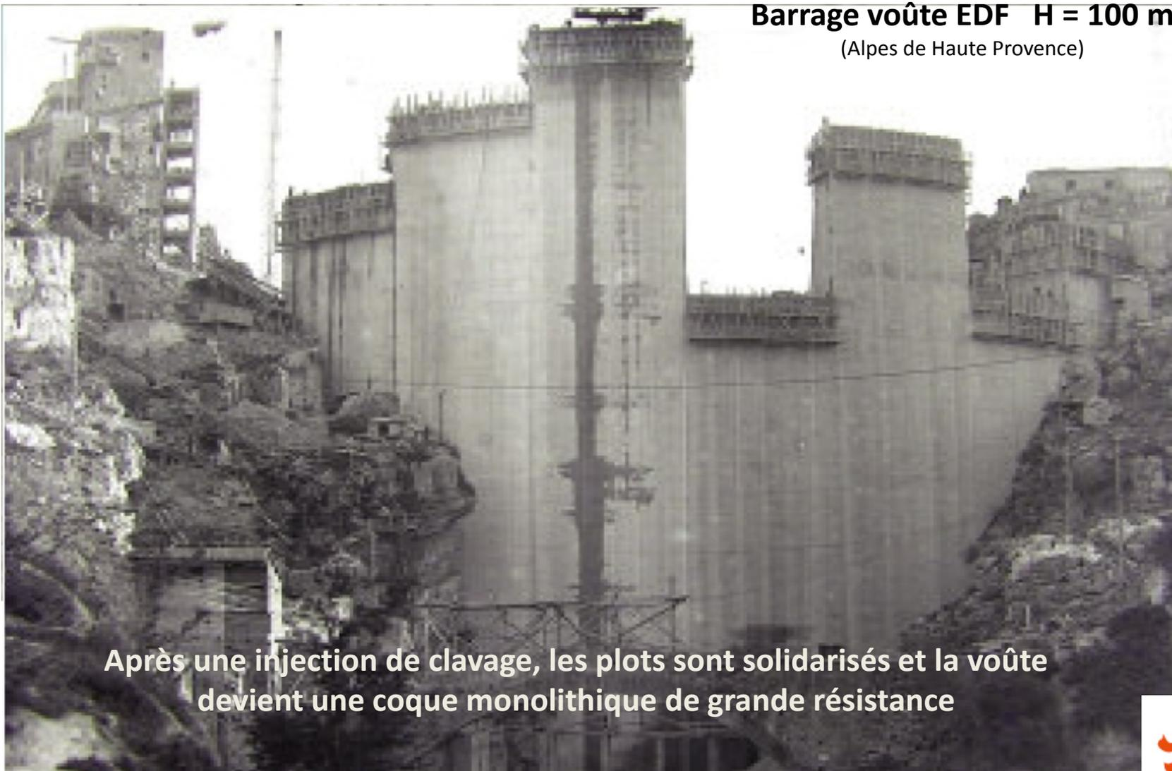
**Après une injection de clavage, les plots sont solidarisés et la voûte devient une coque monolithique de grande résistance**
